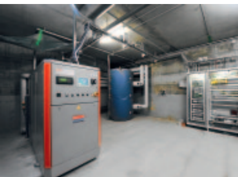
Lokale Stromeinspeiser in Rheinfelden.
