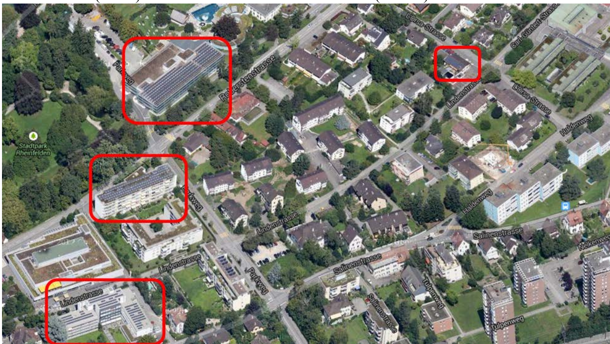
Luftansicht der PV-Anlagen Alters- und Pflegeheim, Zähringer, Parkhaus und L'Orsa-Strasse
