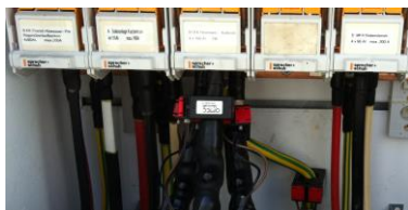
Stromwandlermontage in KK Roberstenstrasse
