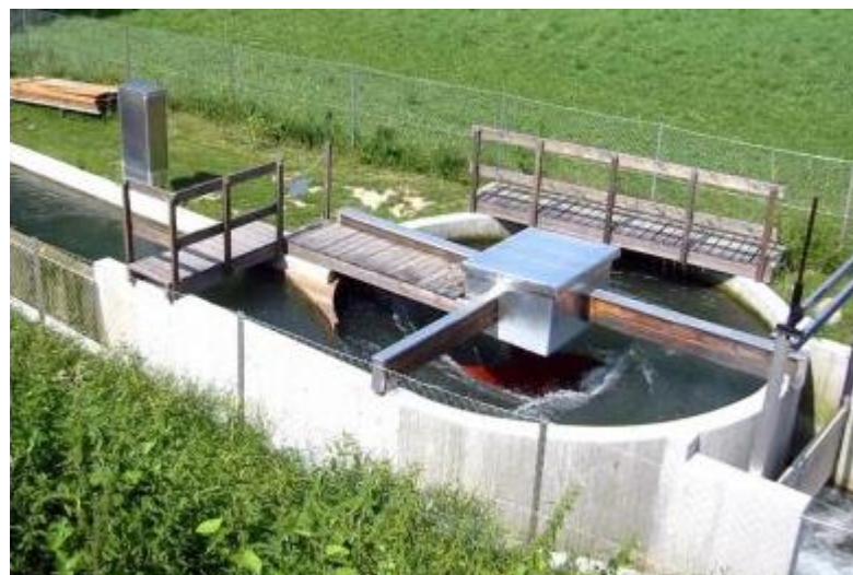
Abbildung 10: Wasserwirbelkraftwerk in Obergrafendorf (A)
