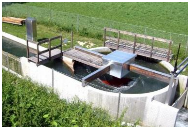
Abbildung 10: Wasserwirbelkraftwerk in Obergrafendorf (A)
